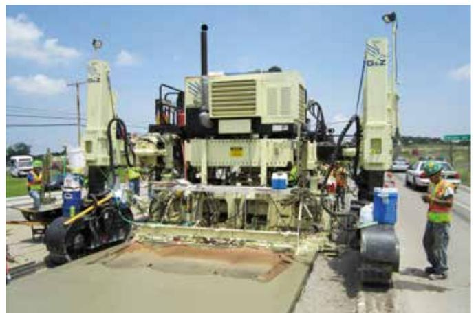
\*Con vibradores hidráulicos, la pavimentadora S600 puede extender hasta 8.0 m con un DBI. Con vibradores eléctricos, la pavimentadora S600 puede extender hasta 9.5 m con un DBI.
